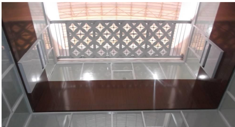
Gambar 15 Hasil pemasangan plafon motif batik kawung.
