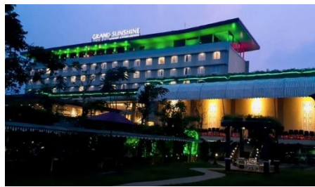
Gambar 1. Tampak depan bangunan hotel Grand Sunshine Resort & Convention (sumber : diakses pada 1 Januari 2024 dari https://www.tiket.com/hotel/indonesia/grand-sunshine-resort-convention )
