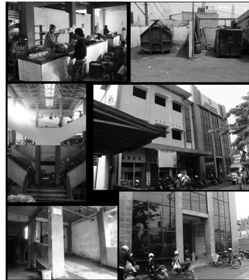
Gambar 4 Dokumentasi area yang ada di Pasar Jrahak (Sumber: dokumentasi penulis)
