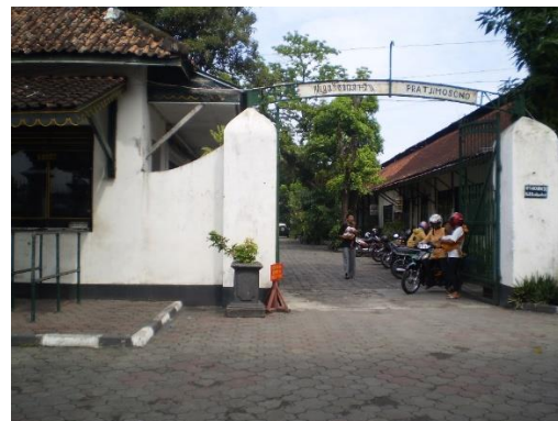
Gambar 3. Gerbang Pintu Masuk Tepas Keprajuritan Keraton Yogyakarta (Tampak depan).
